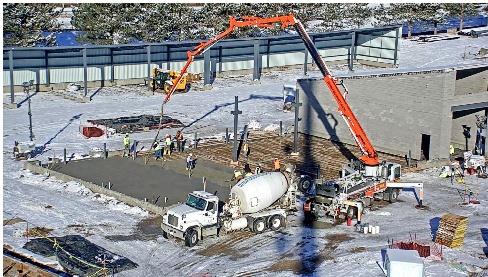
Flatwork concrete pour for the maintenance shop
